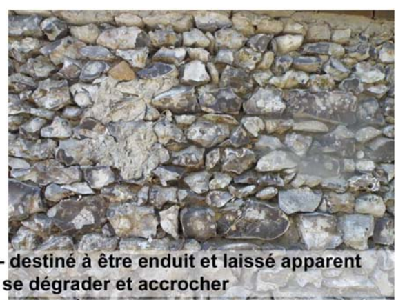
Mur de maçonnerie en moellons destiné à être enduit à pierre vue - détail
